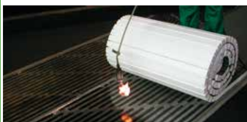
I rotoli di THERMOBASE srotolati sulla superficie appena sfiammata verranno fatti aderire al TECTENE BV STRIP EP mediante pressatura su tutta la superficie del rotolo mediante semplice calpestio dell'operatore (da effettuarsi su tutta la superficie del pannello o rotolo)
