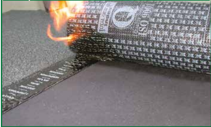
Posa a fiamma delle membrane impermeabilizzanti bitume polimero tradizionali
