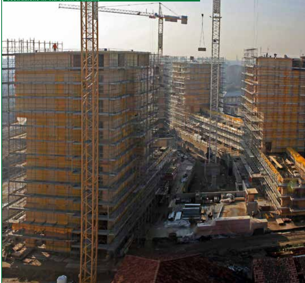
Costruzione in Via Cenni a Milano
