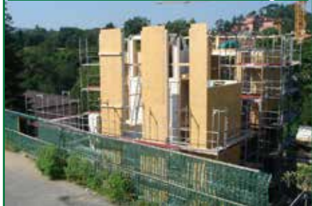
Fasi costruttive della costruzione a Lugano
