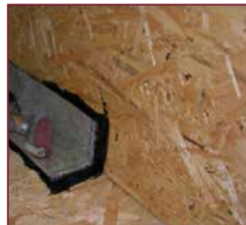
3. Si pressa accuratamente la fascia di rinforzo
