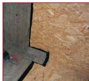
6. La parte verticale incollata con HEADCOLL verrà poi pressata accuratamente
