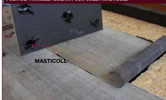
POSA DEI PANNELLI ISOLANTI CON COLLA MASTICOLL
