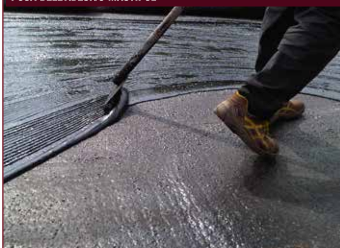
POSA DELL'ADESIVO MASTIPOL
