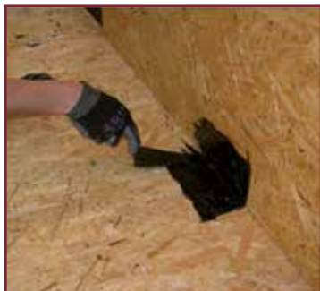
1. Spalmare HEADCOLL a cavallo dello spigolo fra parte piana e verticale
