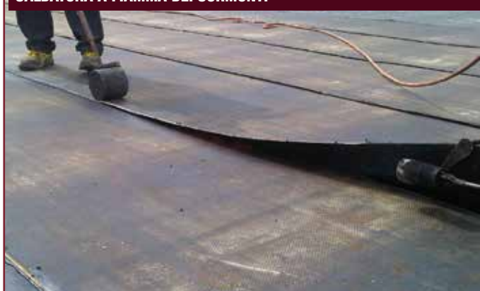
SALDATURA A FIAMMA DEI SORMONTI
