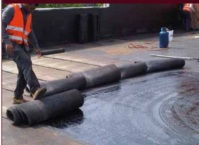
POSA DELLE MEMBRANE FLEXTER TEX
