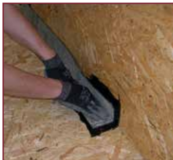
2. Rinforzare il manto sullo spigolo incollando una fascia di membrana h 15 cm
