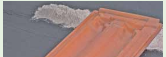
Lenktos plytelės ar čerpės gali būti klojamos ant UNOLASTIC, pritvirtinant jas ant skiedinio juostų
