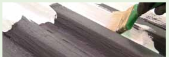
UNOLASTIC gali būti dažomas WHITE REFLEX atspindinčiais dažais arba dažais ELASTOLIQUID S
