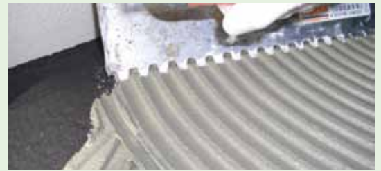
Lenktos plytelės ar čerpės gali būti klojamos ant UNOLASTIC, pritvirtinant jas ant skiedinio juostų
